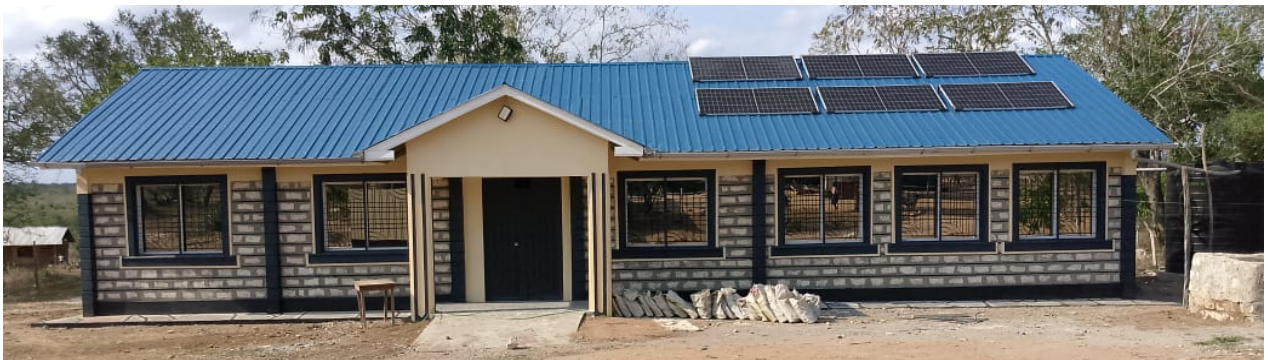
Bouw van een extra klaslokaal
