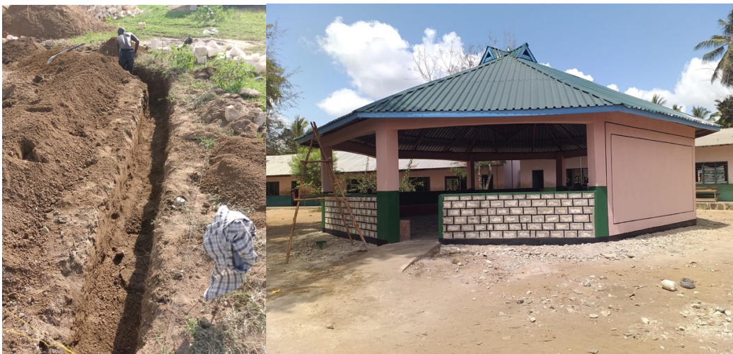
Op de foto links: de werkzaamheden zijn begonnen, de foto rechts is een voorbeeld van hoe het moet worden.
