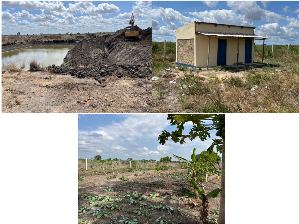
Op de foto links: werkzaamheden in volle gang om de dam te vergroten. Op de foto rechts de schuur. Op de onderste foto: impressie van de tuinbouw.
