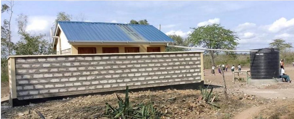
Bouw van een administration block
