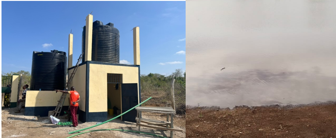
Op de foto links de wateropslag in tanks met daaronder een schuur, op de foto rechts het al behoorlijk gevulde bassin.
