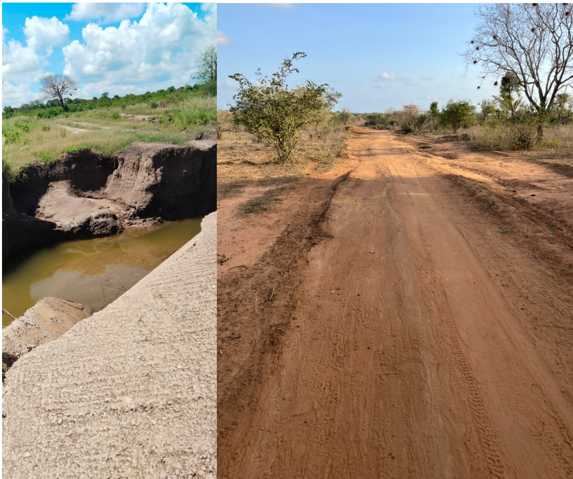
Links een van de vernielde bruggen, rechts de nieuwe weg.
