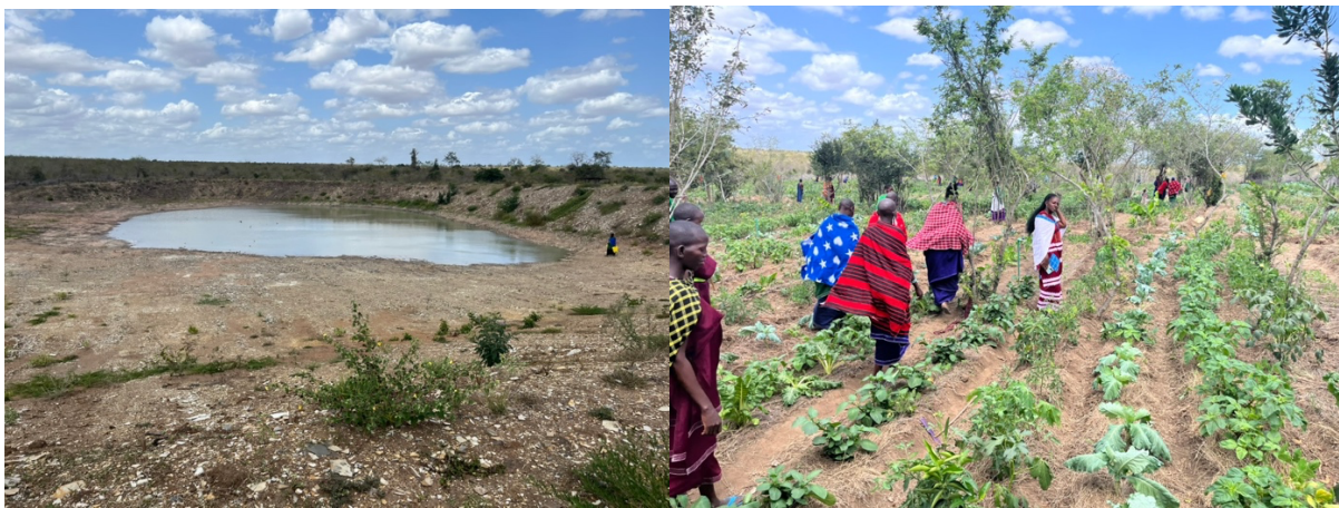
Het project in Naserian. Hier is de watervoorraad minder omdat het regenseizoen bijna voorbij was toen het graven van het bassin klaar was. Ook zit er een kleine lekkage in de damwand. Het Ministerie van Water gaat dit probleem oplossen.
